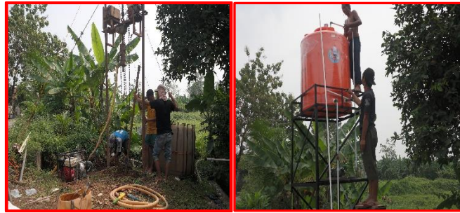
Gambar 4. Pembuatan Sumur Bor dan Pembangunan Konstruksi Reservoir Air
