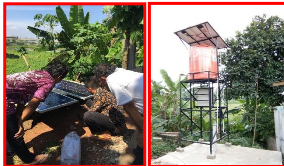
Gambar 5. Pemasangan Panel Surya
